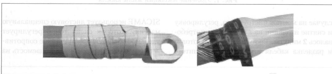
Рис. 12. Герметизация корпуса муфты
