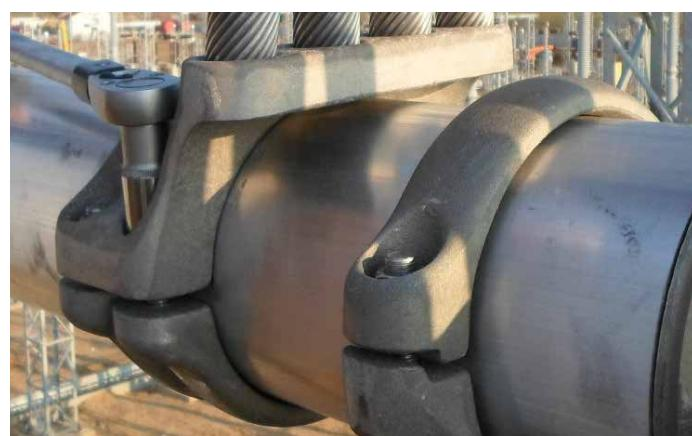
Перевірка якості затягування болтів ANSI/NEMA CC1 §3.5
