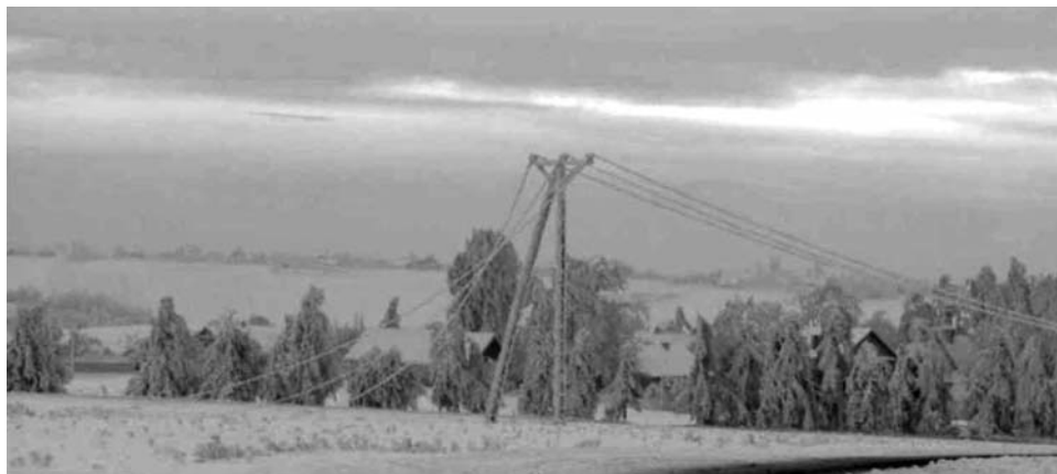
Рис. 4-3: Обрыв провода из-за обледенения
