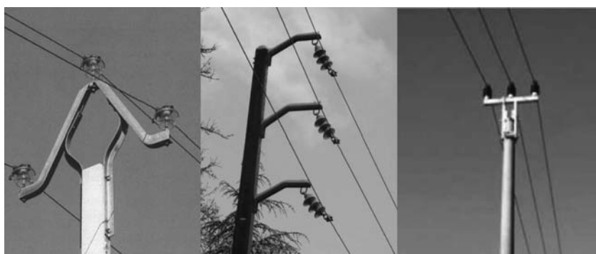
Рис. 3-1: Линии с трёхпроводной системой размещения проводов
