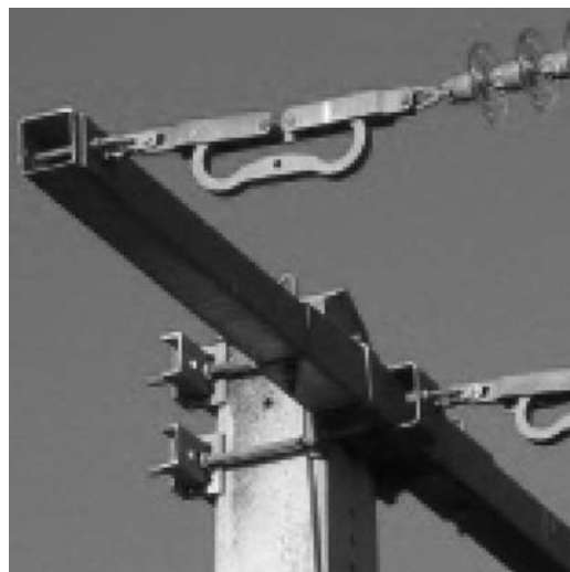
Рис. 19. Деформируемое соединение «Омега» во Франции
