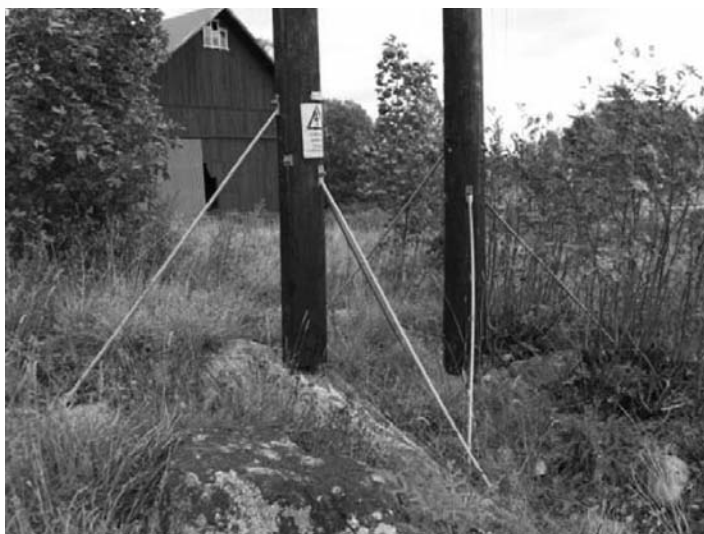
Рис. 1. Крепление опор оттяжками
