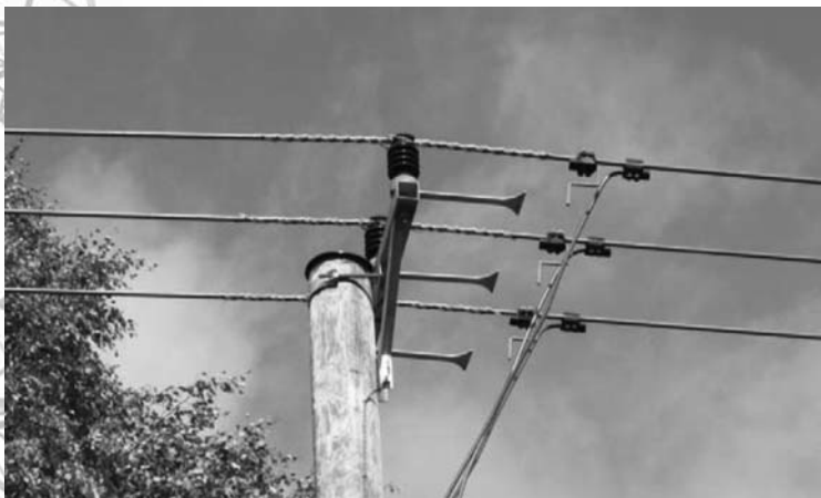
Рис. 12. Дугозащитное устройство в Швеции
