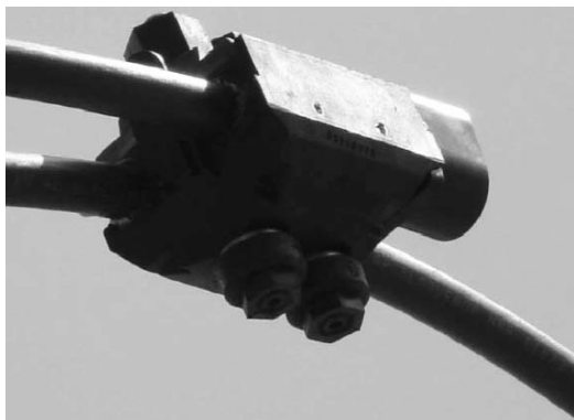
Рис. 37. Отпайка при помощи TTDC в Бразилии
